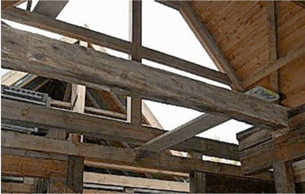
Balkenkonstruktion im Wohnstallhaus. Foto: Steffen Foto: Steffen
